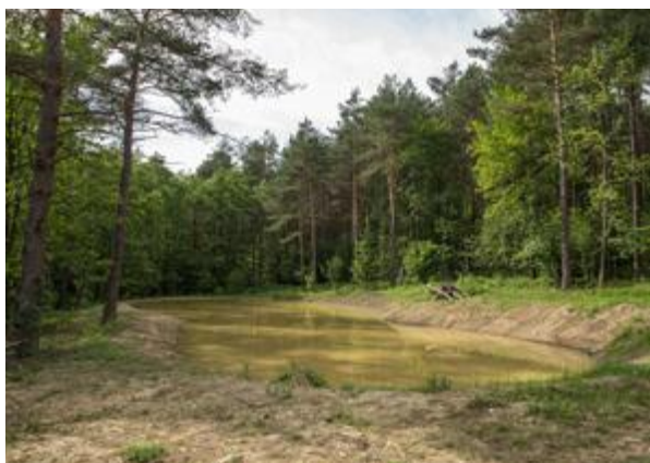
Fot. 117. Mikroretencja w bezodpływowych zagłębieniach terenu – kaskada zbiorników w szerokim wąwozie w Nadleśnictwie Piwniczna (archiwum CKPŚ)
