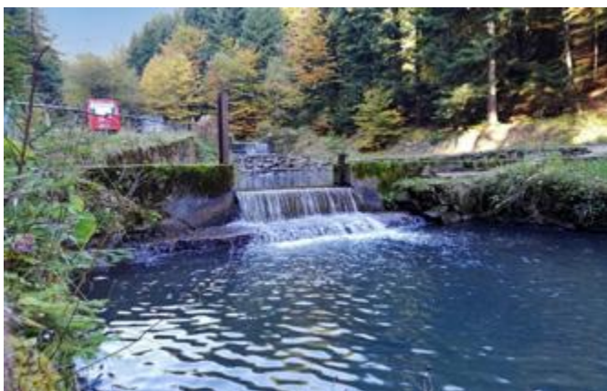
Fot. 90. Bystrze o zwiększonej szorstkości w miejscu rozebranego betonowego jazu w Nadleśnictwie Krasiczyn, przywracające ciągłość biologiczną cieku (archiwum CKPŚ).
