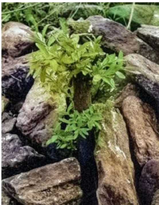
Fot. 77. Zabezpieczony faszyną narzut kamienny z nasadzeniami wierzbowymi, Nadleśnictwo Baligród (archiwum CKPŚ).
