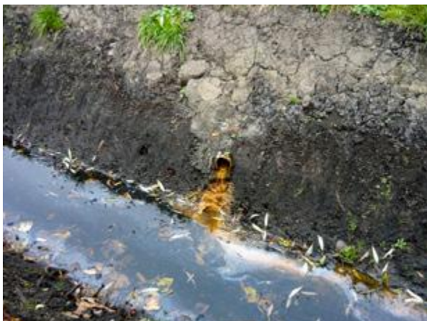
Fot. 53. Przypadkowo odkryty wylot drenarski/rurociąg drenarski na terenie gruntów należących do Przedsiębiorstwa Rolno-Przemysłowego „Agromax”, powiat raciborski (fot. Ł. Borek).
