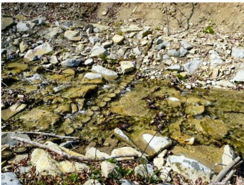
Fot. 47. Gurt ubezpieczający próg – gurt zabezpieczony narzutem kamiennym – rozwiązanie zbliżone do przedstawionego na rys. 48a (archiwum CKPŚ).
