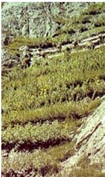
Fot. 64. Krzewiaste umocnienia tarasowe na skarpie/osuwisku [Begemann i Schiechtl 1999].
