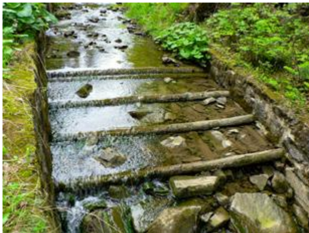
Fot. 129. Kaskada bardzo niskich progów, łatwa do pokonania dla organizmów wodnych, brak przelewów na małą wodę (fot. T. Kowalik).
