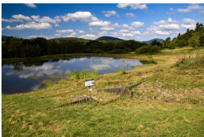
Fot. 119. Końcowy zbiornik w układzie kaskadowym w Nadleśnictwie Baligród zasilanym z cieką, a dodatkowo także wodą doprowadzoną z rowu przydrożnego – na pierwszym planie widoczne miejsce zasilania zbiornika wodą z rowu (fot. M. Mikulska)
