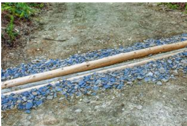
Fot. 107. Wodospust odprowadzający wodę z drogi do lasu, Nadleśnictwo Łosie (archiwum CKPŚ)
