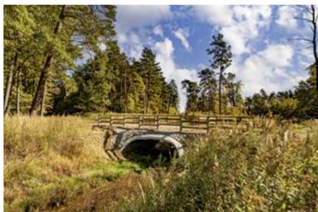
Fot. 141. Nowoczesne konstrukcje odporne na zatkanie rumoszem, Nadleśnictwo Lubaczów (fot. J. Smarczewski, 2021)
